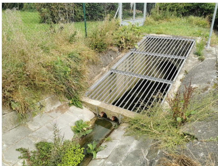
Obr. 1 – Opevněné koryto koncové části otevřeného koryta před zaústěním do DN 1000
